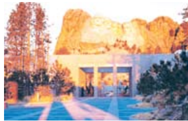
1997 러쉬모어산 국립기념관 방문센터 블랙힐스, 사우스다코타주, 미국 강당 위에 플라자와 데크 시공
